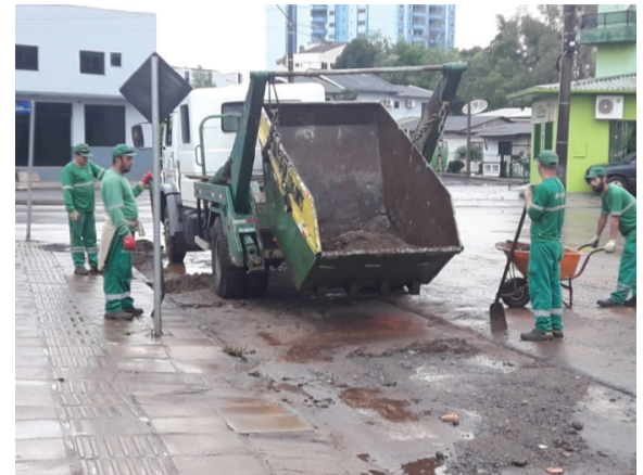
Equipe trabalha na limpeza da Rua Emilio Allet
