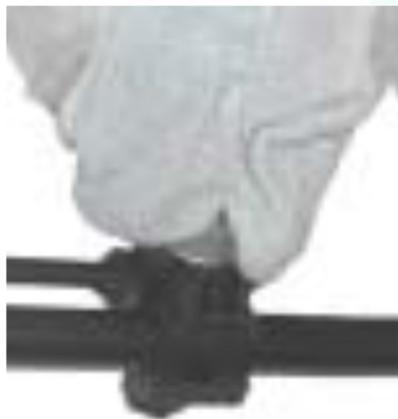
**4-** Coloque o capuz na ponta do condutor derivado, tomando cuidado ao inseri-lo, pois uma força excessiva pode danificar sua isolação.
